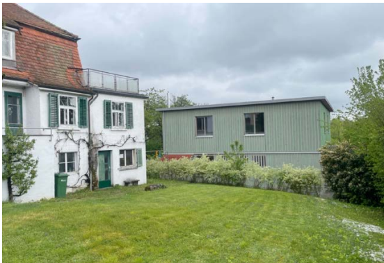
Bauplatz, Blick von Alte Winterthurerstrasse
