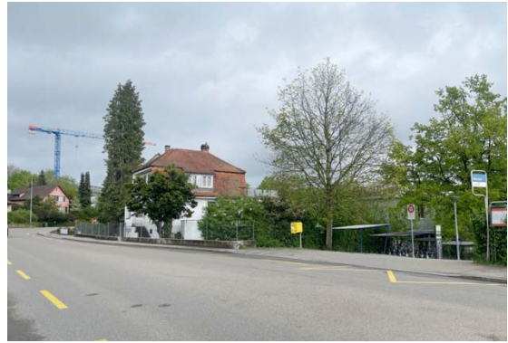
Alte Winterthurerstrasse, Blick von Süden
