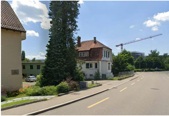
Alte Winterthurerstrasse, Blick von Norden
